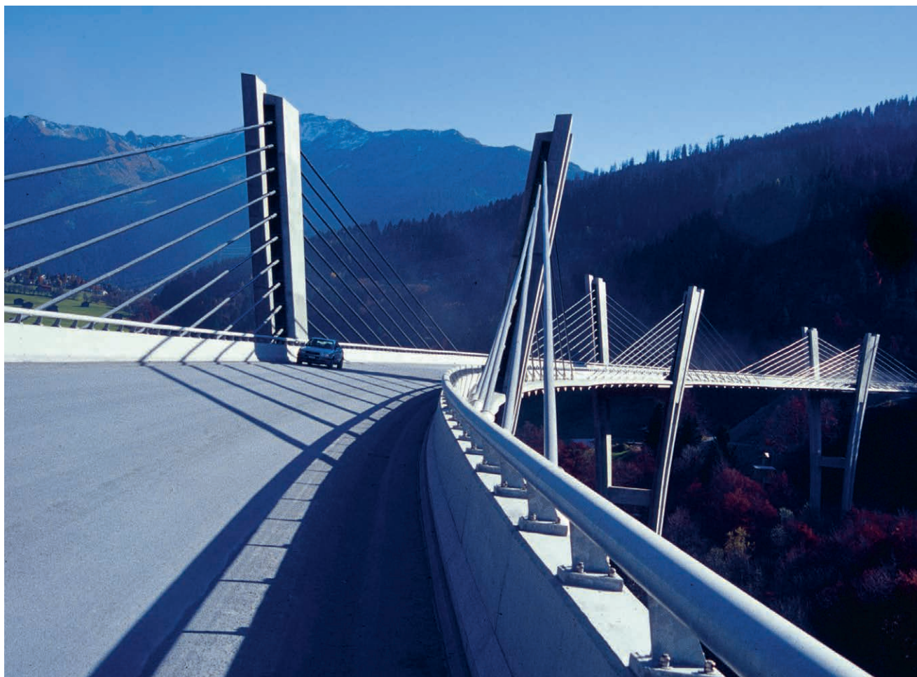
Contournement de Klosters, pont du Sunnibergbrücke, tunnel du Gotschna | Architecture et photographie: Christian Menn
