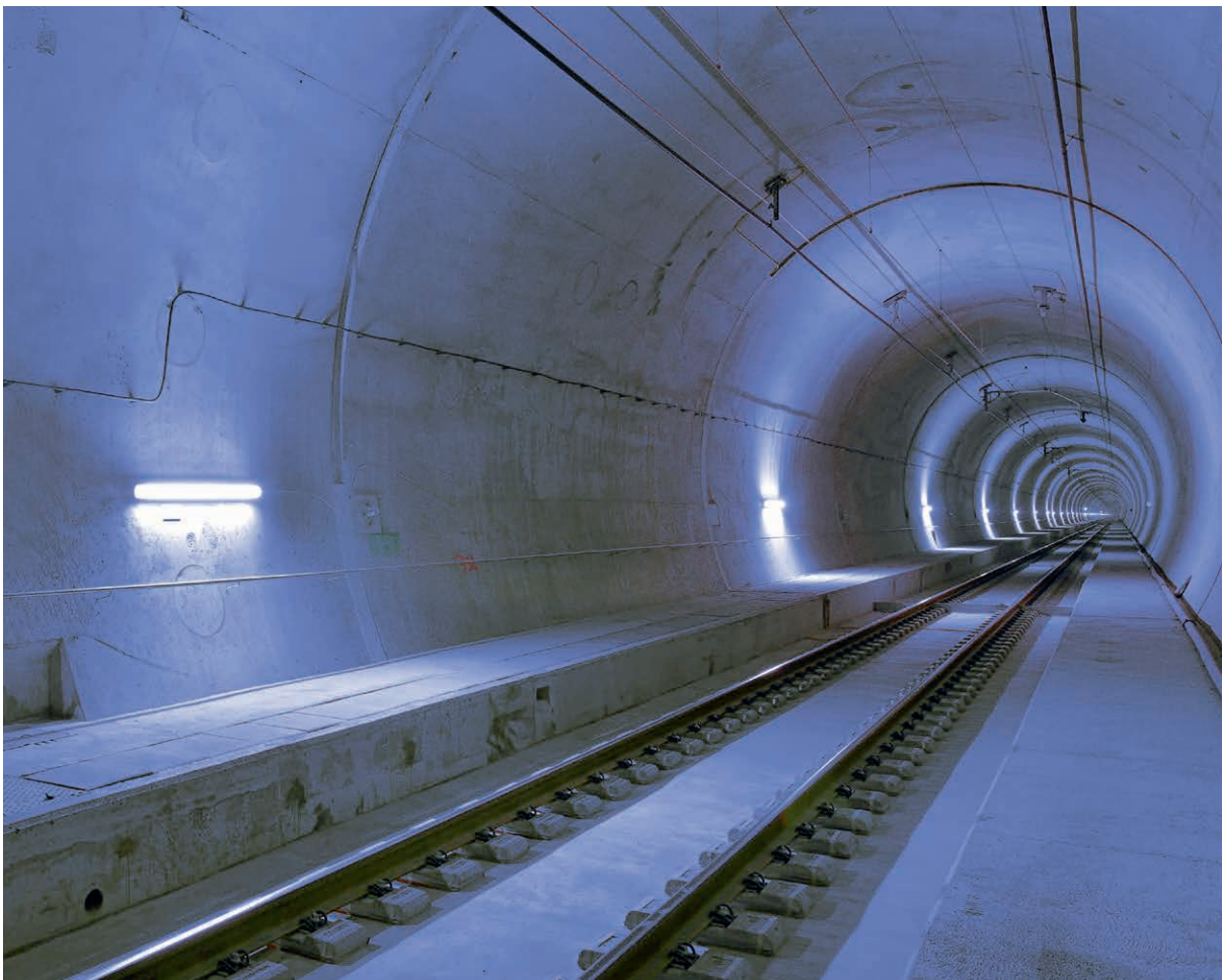
Tunnel di base del Lötschberg | Fotografia: BLS Alp Transit AG
