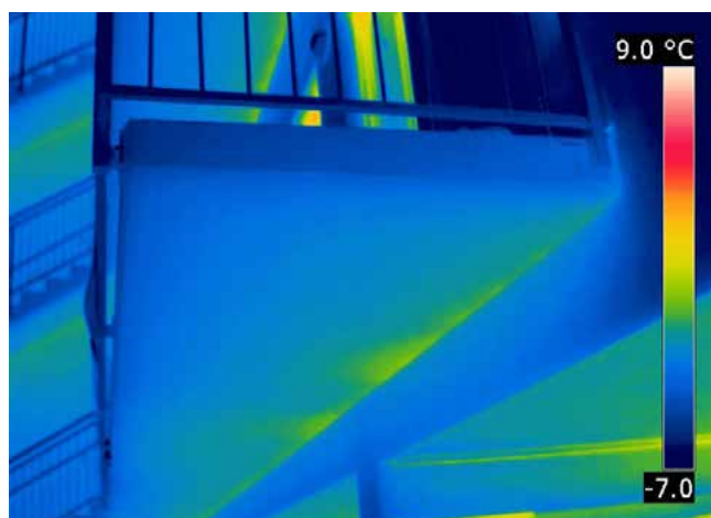
Thermographie d'un raccordement de dalle à porte-à-faux avec FIRIKA®
