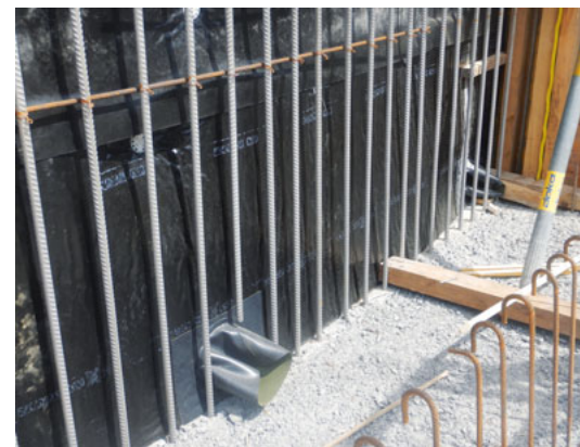
Enkadrain CK 20 mit aufgeschweissten Manschetten vor und nach Einschleiben der Entwässerungsrohre.
