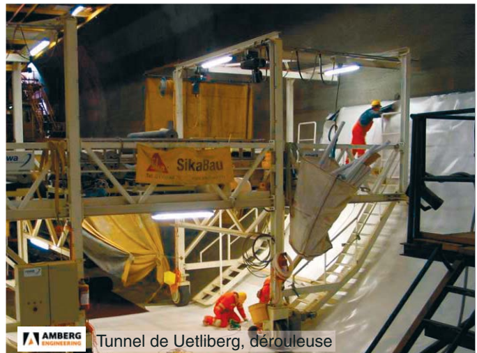
AMBERG Tunnel de Uetliberg
