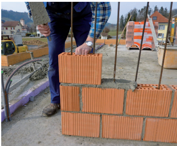
Mindestens drei Schichten aufmauern, wenn die Bewehrung gestossen wird. Die Überlappung der Bewehrungsstäbe muss mindestens 60 cm betragen.
