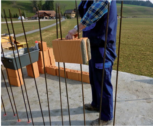
4. Einfädeln des Steines mit aufgebrachtem Stossfugenmörtel (Spatz).
