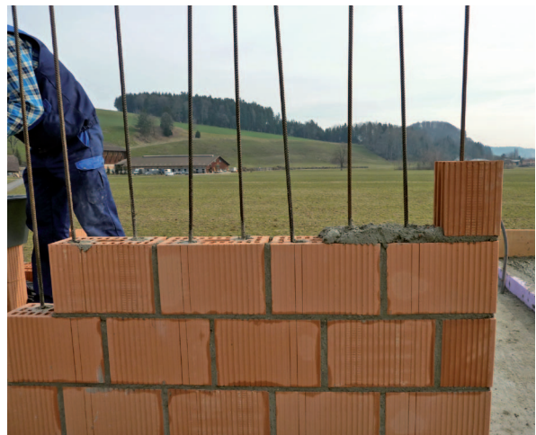
Mindestens drei Schichten aufmauern, wenn die Bewehrung gestossen wird. Die Überlappung der Bewehrungsstäbe muss mindestens 60 cm betragen.
