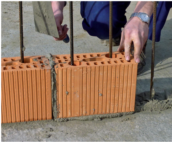
6. Das Mauerwerk muss vollfugig erstellt werden
