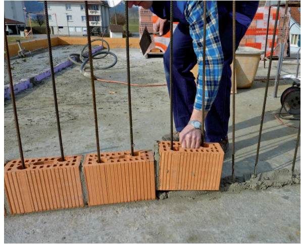
5. Setzen des ARMO-Steines
