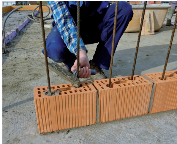
7. Die Bewehrungslöcher müssen vollständig verfüllt werden.
