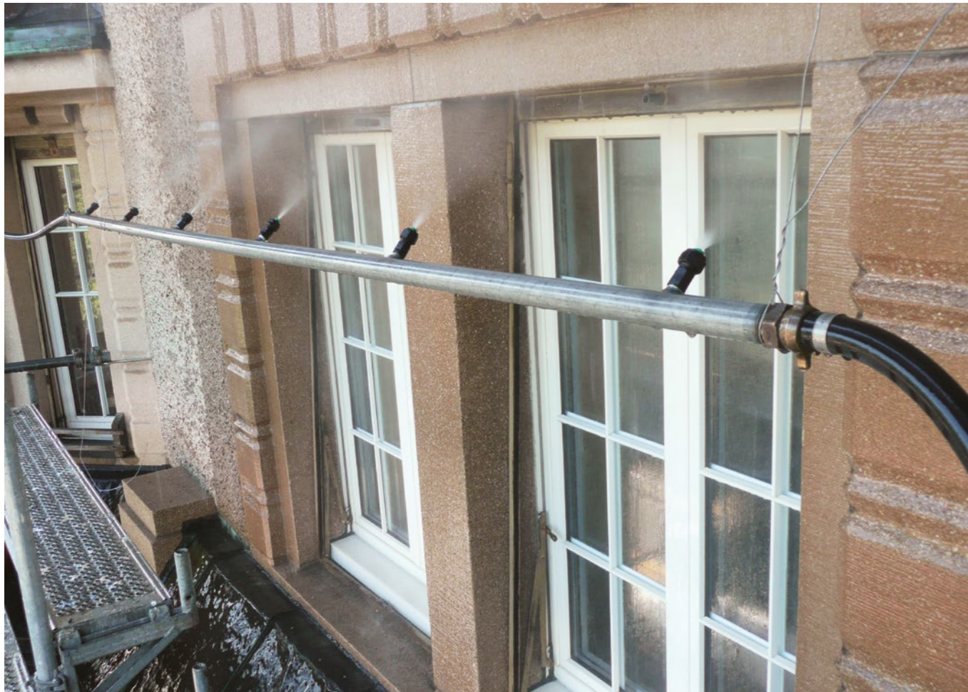
Spezialreinigung einer Natursteinfassade
