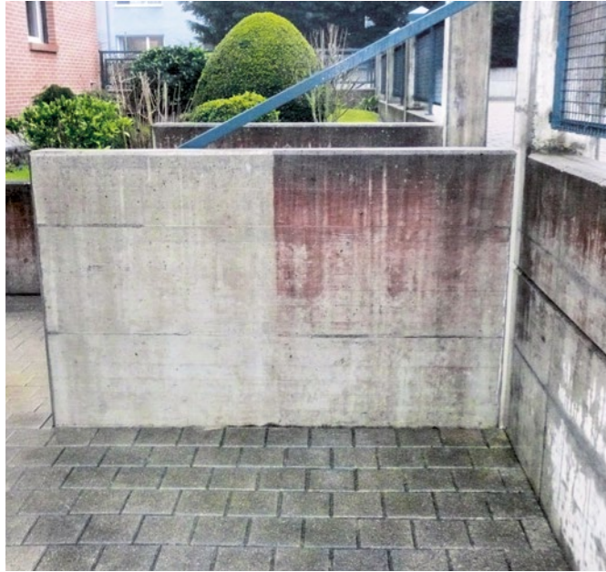
Reinigung einer mit Algen verschmutzten Betonoberfläche
