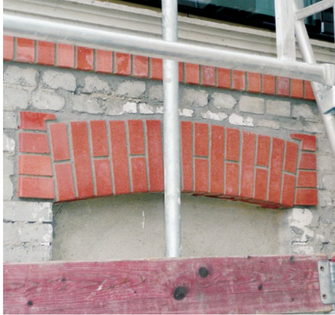
Ersatz eines Rundbogensturzes
