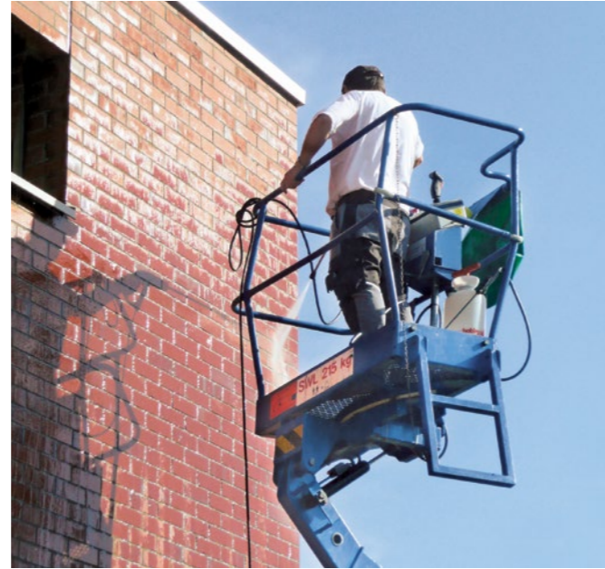
Endreinigung eines Sichtmauerwerkes
