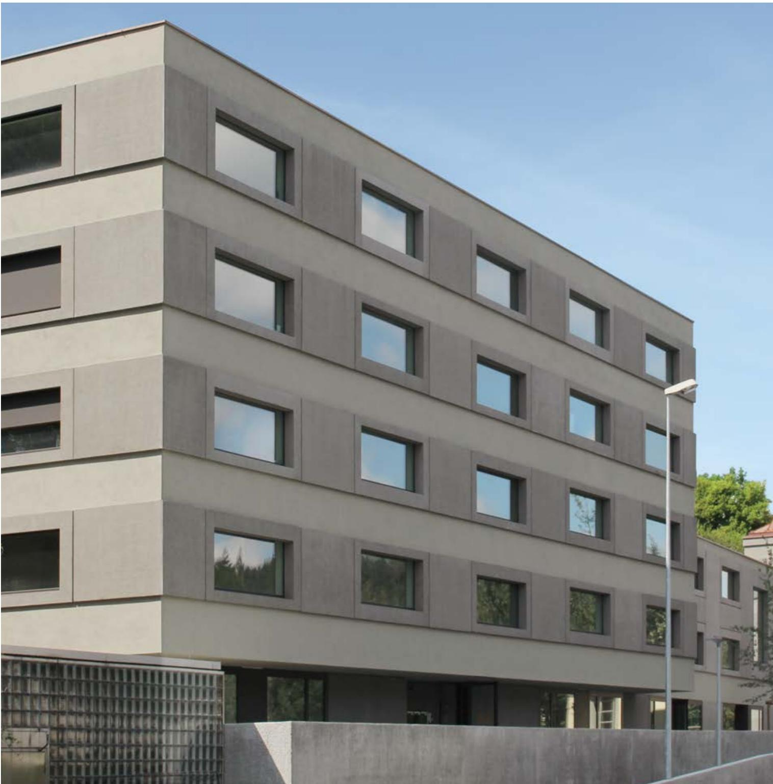
Die Fassade der Neuapostolischen Kirche in Aarau ist eine Kombination aus eingefärbten Sichtbetonelementen mit leicht sandgestrahlter Oberfläche in Kombination mit Verputz. Die Gross GU AG beauftragte die Keller Systeme AG mit Ausführungsplanung, Herstellung und Lieferung der über 300 Betonelemente.
