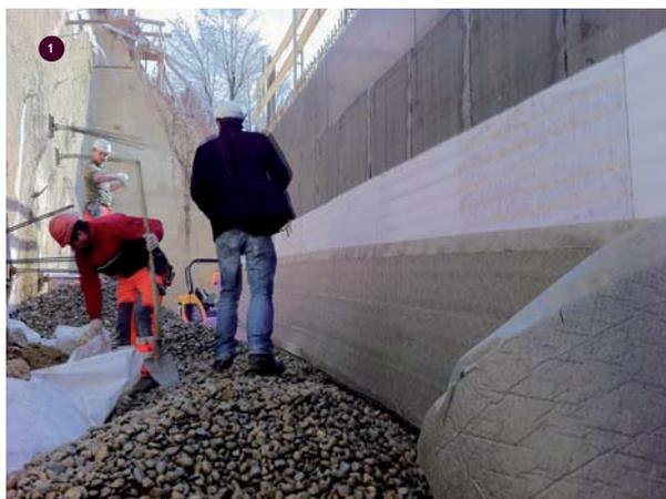
1. Links die gesicherte Felsböschung, rechts die Perimeterdämmung mittels Enkadrainmatten für eine akustisch abgekoppelte und gleichzeitig gegen stehendes Grundwasser geschützte Fassadenwand.
