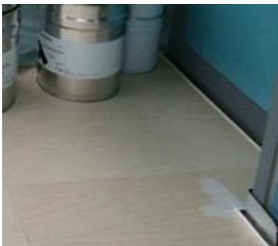
Die Oberfläche wird dann mit CONIPUR 67 versiegelt. Der Auftrag von CONIPUR 67 erfolgt durch Rollen auf den vorbereiteten Untergrund, wobei ein **gleichmäßiges**, bahnenweises Verarbeiten sehr wichtig ist.
