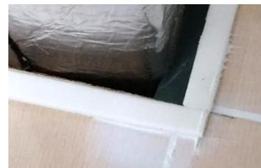
Dann wird **CONIPUR 3335** mit einer Stiftrakel aufgebracht.
