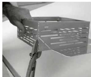
Perforation der hinteren Ecken bis zur Schräge durchtrennen.
