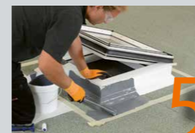
5 erste Schicht auftragen
