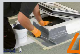
4 erste Schicht auftragen
