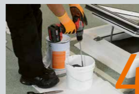
4 Flüssigkunststoff anrühren
