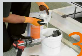
3 Katalysator zugeben
