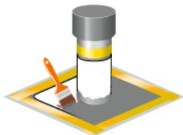
Insérer le reste de la découpe 2 du voile d'armature avec recouvrement et imprégner de résine BauderLIQUITEC PU.
