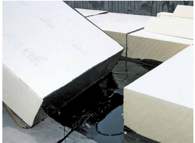
Couler le bitume chaud à  $180^\circ \text{C}$  sur le pare-vapeur, consommation selon support, environ  $5 \text{ kg/m}^2$ .
