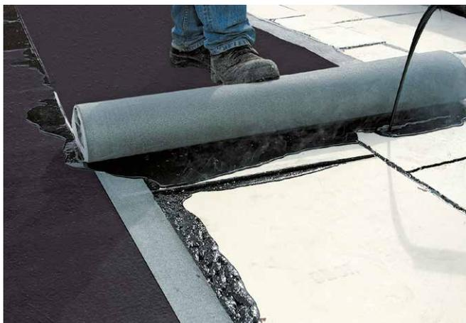
2,5 kg/m<sup>2</sup>. Dérouler le lé de telle manière qu'un boudin de bitume se forme devant le rouleau, le lé doit être collé sans aucune bulle d'air.
