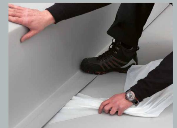
Anschluss an die Attika mit SK-Zuschnittbahn, Zuschnitt vorformen, Schutzfolie oben und unten parallel zur Kehllinie einschneiden und schrittweise abziehen, Zuschnitt andrücken.
