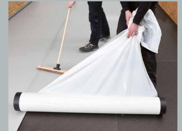
Abziehen der Schutzfolie parallel zur Rolle, Andrücken der Dachbahn auf den Untergrund mit einem sauberen, breiten Besen oder einer Rolle.
