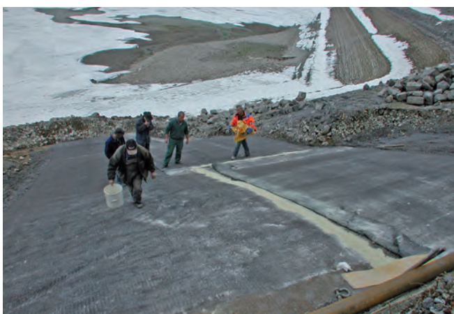
Étanchéification de flanc, Klöntalensee ▲
