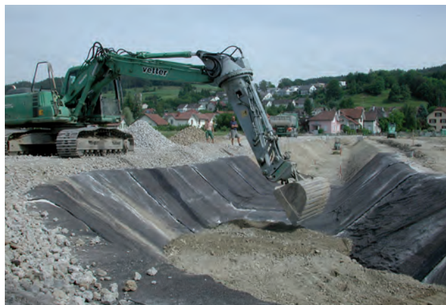
Aménagement de canal, Sirmach
