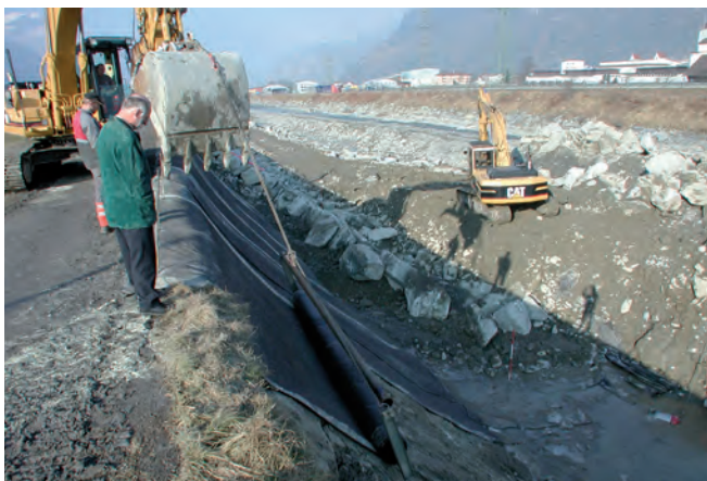
Étanchéification de flanc, Klöntalensee ▲
