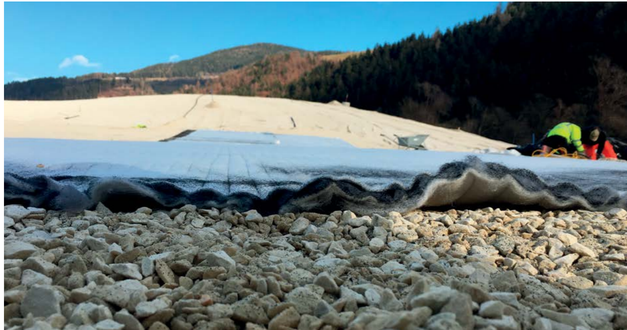
Schadstoffbarriere in der Altlastensanierung
