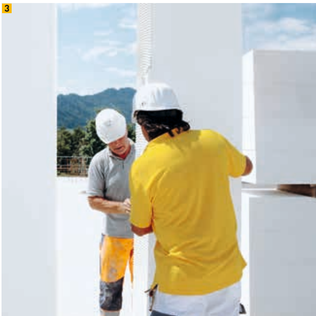
En plus du grutier, seuls deux monteurs sont nécessaires pour déplacer les éléments.
