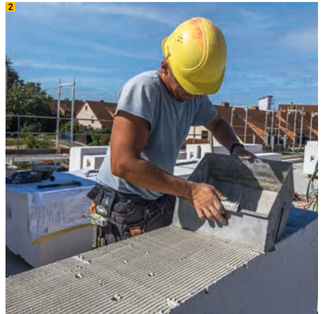
Pour assembler les éléments, un mortier en couche mince est appliqué sur les côtés des joints bout à bout.
