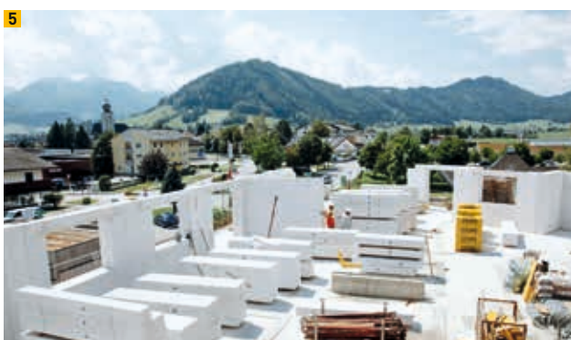
Les éléments muraux du système Ytong garantissent une efficacité maximale : Avec un groupe de travail (3 hommes), jusqu'à 150 m 2 d'espace mural peuvent être érigés par jour ouvrable.
