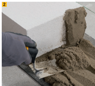
2 Vermörteln von Stossfugen
