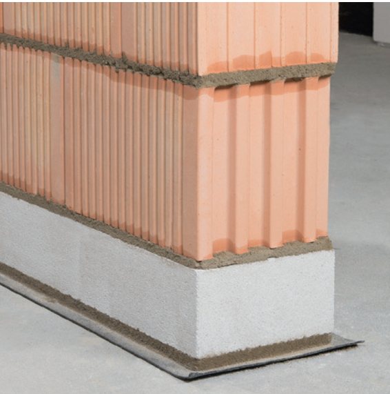
Backsteinmauerwerk mit Ytong Thermofuss
