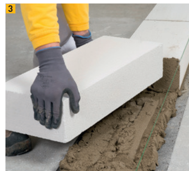
3 Nachfolgende Ytong Thermofuss Steine werden entlang der Mauerschnur angesetzt
