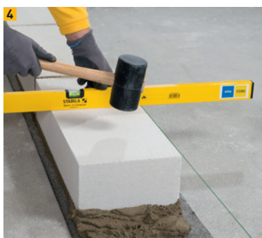
4 Die Steine werden in Höhe und Lage ausgerichtet
