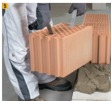
5 Aufmauern der Wand mit normgeregelten Backstein oder Leichtbetonsteinen
