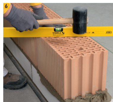
5 Aufmauern der Wand mit normgeregelten Backstein oder Leichtbetonsteinen
