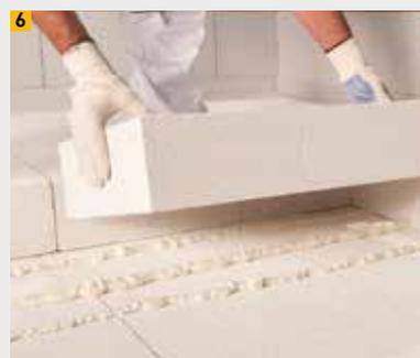
**6** Dämmplattenverlegung in PU-Dämmstoffklebeschäum, hier als Montagefixierung
