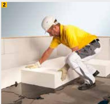
**2** Dämmplattenverlegung in Heissbitumen
