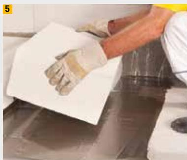
**5** Dämmplattenverlegung in Flüssigdampfsperre
