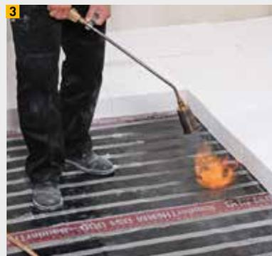
**3** Dämmplattenverlegung auf oberseitig thermisch aktivierbare Dampfsperre
