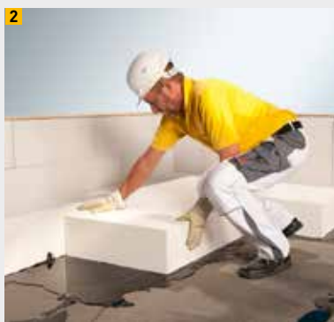
2 Panneau isolant dans le bitume chaud
