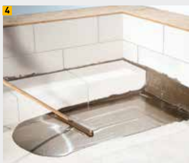
4 Appliquer une barrière contre les vapeurs liquides
