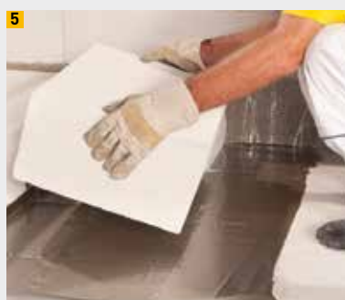
5 Panneau isolant posé dans un pare-vapeur
