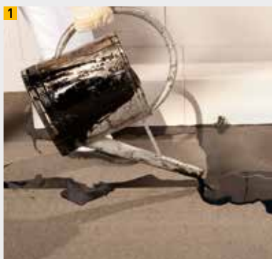
1 Appliquer du bitume chaud
