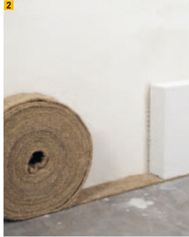
2 Entkopplungsstreifen, z. B. aus Hanf, setzen
