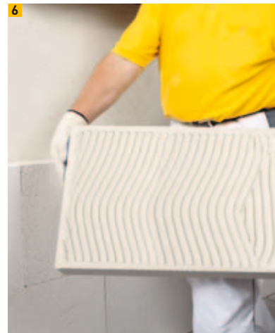
6 Mörtel vollflächig auf Mineraldämmplatte
