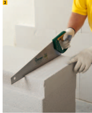
3 Schneiden von Multipor Mineraldämmplatten
