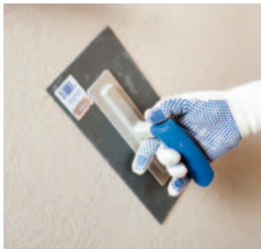
Strukturieren mittels Traufel
