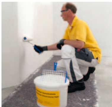
Auftragen der Multipor Innensilikatfarbe
