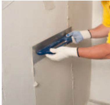
Aufziehen des Oberputzes
