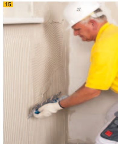
Aufziehen der Armierungsschicht
