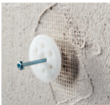
Setzen des Dübels durch das Gewebe
