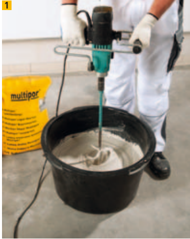
1 Anmischen Multipor Leichtmörtel
