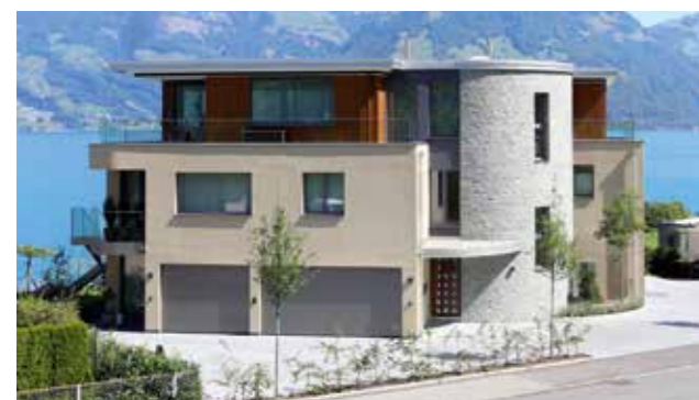
Immeuble collectif, Beckenried
