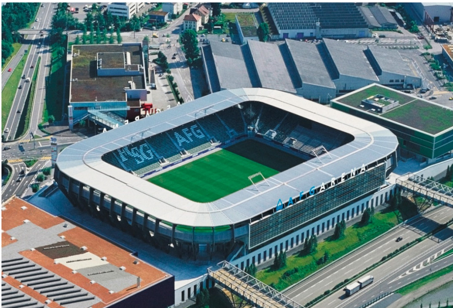
Foto © Stadion St. Gallen AG
