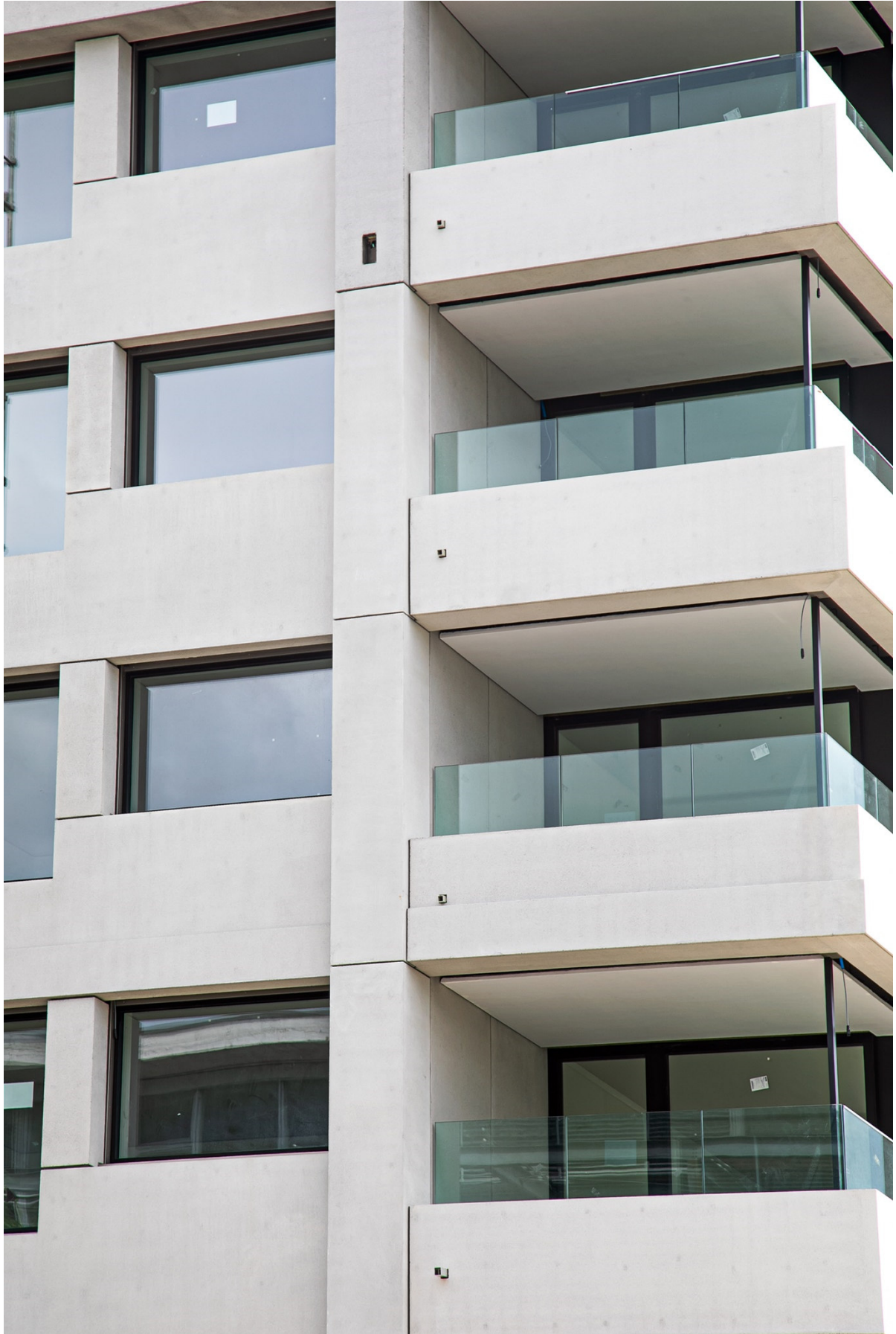
Referenz Hochhaus Basler Strasse Zürich, Quelle Hanno
