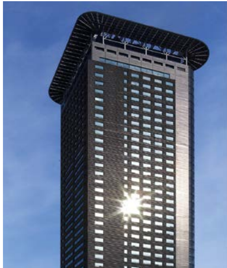
^ Hochhaus „Het Strijkijzer“ (Den Haag)
