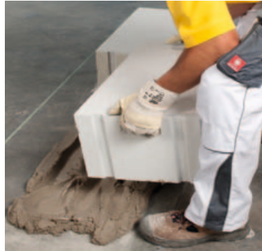
Pose de la première pierre sur la brique d'angle orientée
