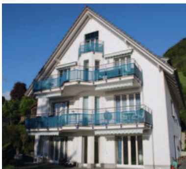
Façade Ytong après 10 ans Immeuble, Kehrsiten NW
