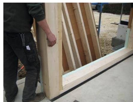
Afin de prévenir ces risques, il convient de réaliser une rupture de capillarité soit avec un chaînage en béton armé disposé au niveau du plancher bas du rez-de-chaussée ou du dallage, soit mettre en œuvre une coupure par bande d'arase, disposée à 15 cm au moins au-dessus du sol extérieur définitif.
