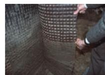
**Nappe de protection "simple"** : risque de poinçonnement de certains revêtements d'étanchéité par les alvéoles orientées vers la paroi.
