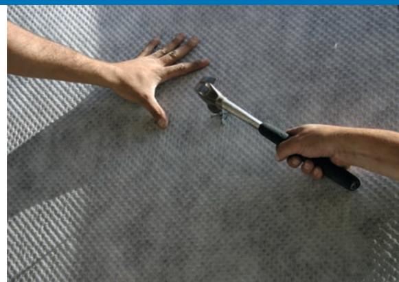
❶ La nappe drainante DELTA® est appliquée sur un revêtement d'imperméabilisation du type *noir de fondation* : la fixation mécanique en tête de nappe peut être réalisée sous le niveau fini du sol et l'imperméabilisation peut être perforée. Le profilé synthétique DELTA® (couleur brune) doit être protégé des UV. Si cela ne peut être le cas, utiliser le SOLIN ALU DELTA®.
