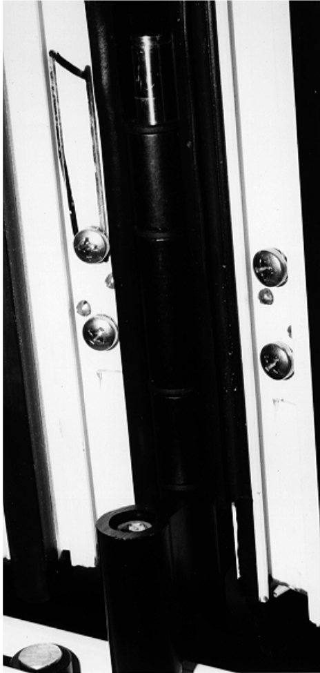
Abbildung 21: Verbinden der Flügelpakete mit den Laufwagen
