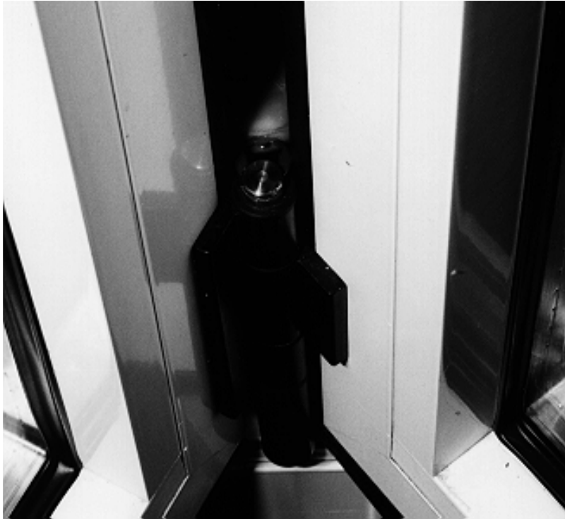
Abbildung 25: Sicherung der Bandbolzen am unteren Laufwagen
