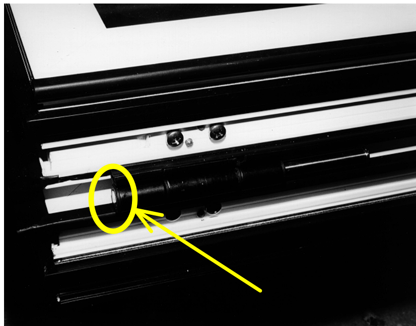
Abbildung 20: Zurückgeschlagener Bandbolzen vor dem Einhängen der Flügelpakete
