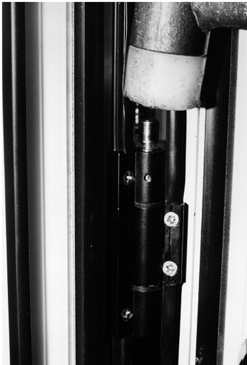
Abbildung 24: Zusammenhängen der einzelnen Flügelpakete
