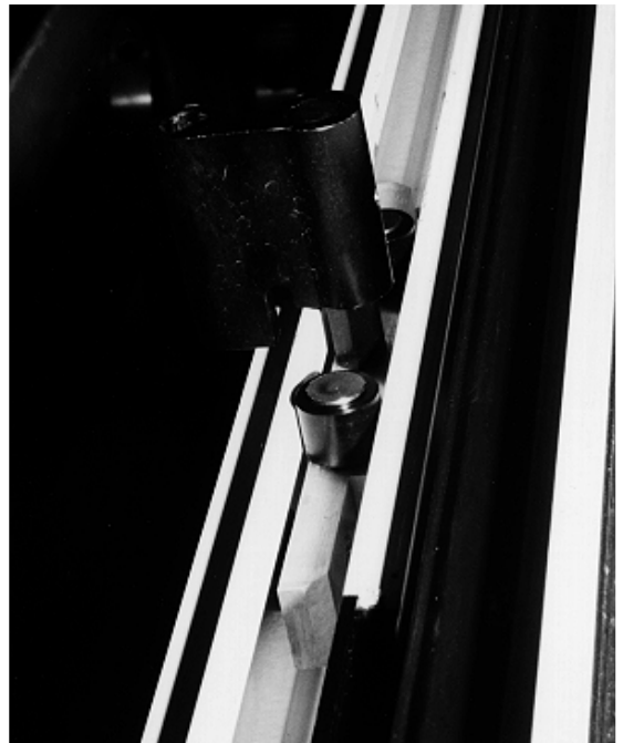
Abbildung 19: eingeführter Laufwagen vor dem einhängen der Flügelpakete
