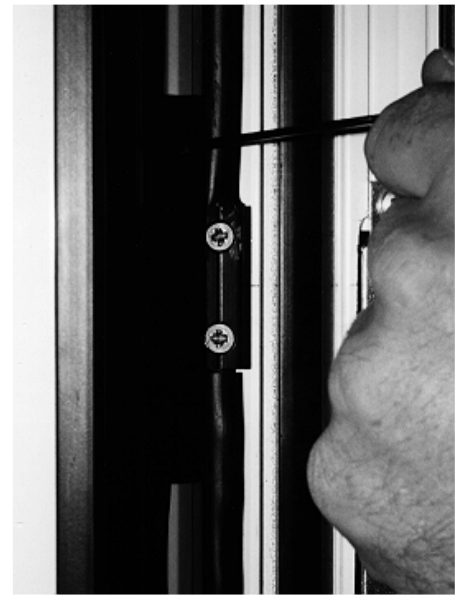
Abbildung 27: Sicherung des Mittelbandes
