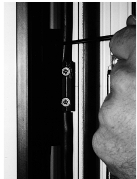
Figure 19 : Fixation de la paumelle centrale
