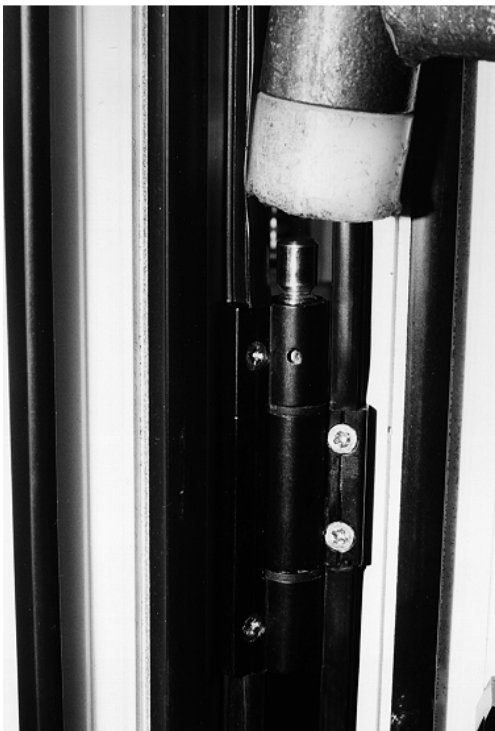
Figure 16 : Accrochage des ensemble de vantaux individuels
