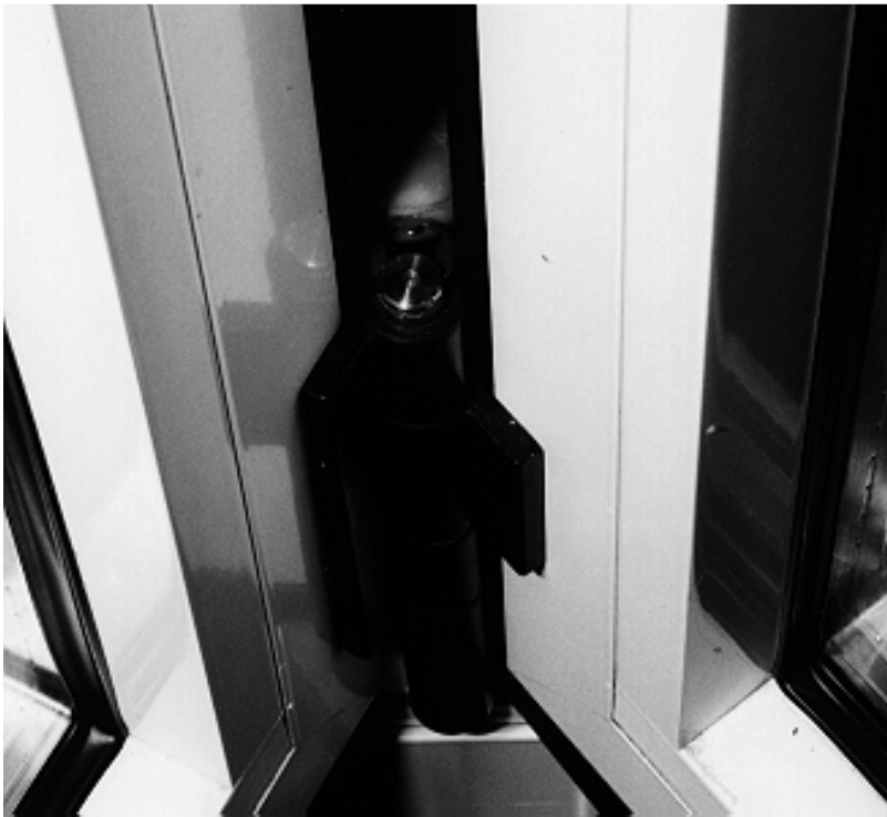
Figure 17: Fixation des axes de paumelle sur la chape de roulement inférieure
