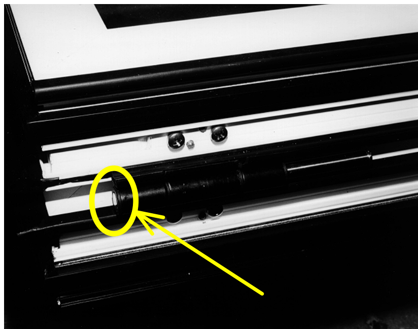
Figure 20 : Axe de paumelle repoussé avant accrochage des ensembles de vantaux
