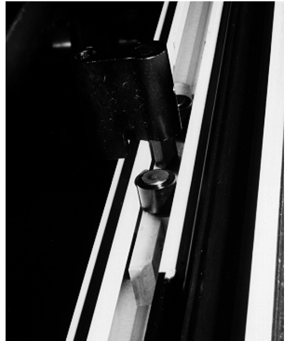
Figure 19 : Chape de roulement introduite avant accrochage des ensembles de vantaux
