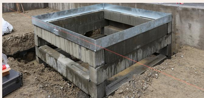
Pflanzgrubenelement Typ 120 mit Einbaurahmen Typ 312
