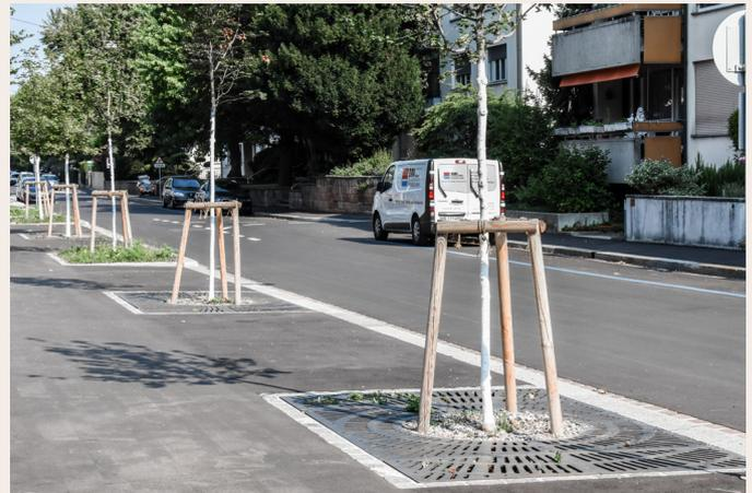
Das Arconda®-Baumschutzsystem ist bis zur Klasse B 125 konzipiert. Für die höheren Klassen wurden keine Prüfungen unternommen. Es ist somit nicht einsetzbar.
