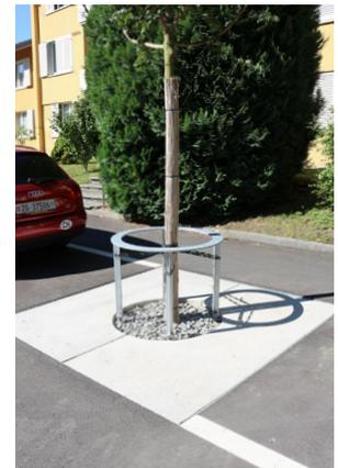
Abdeckung aus Beton-Halbplatten
