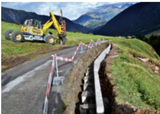
Stützmauererrichtung zur Strassensicherung in Sedrun.
