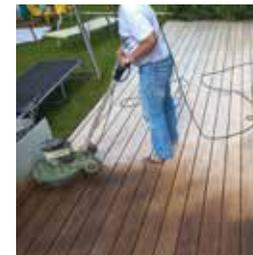
Ölen mit der Tellermaschine (auch von Hand möglich)
