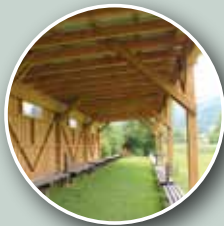
Construction en bois
