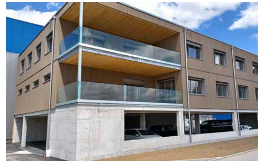
Centre de stockage et de distribution à Farvagny-le-Petit
