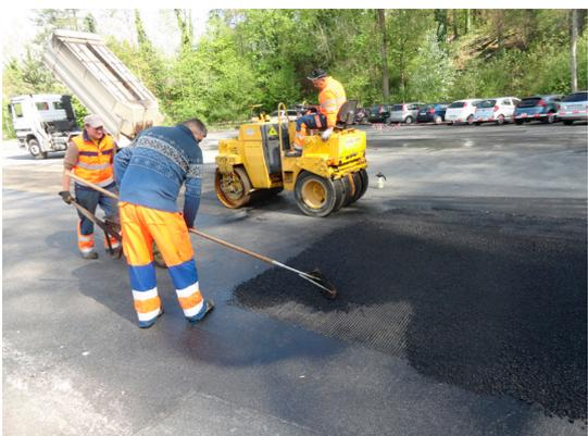
Je nach Situation und Witterung sind geeignete Schutzmassnahmen, gegen z.B. Aufreissen der Bewehrung durch überrollende Fahrzeuge, vorzusehen. S&P empfiehlt, die lokal verlegte Bewehrung mit Asphalt abzustreuen.
