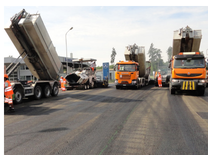
5 Application de la couche d'enrobé le même jour
