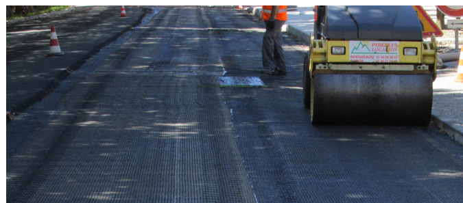
Application d'armature S&P en pleine largeur
